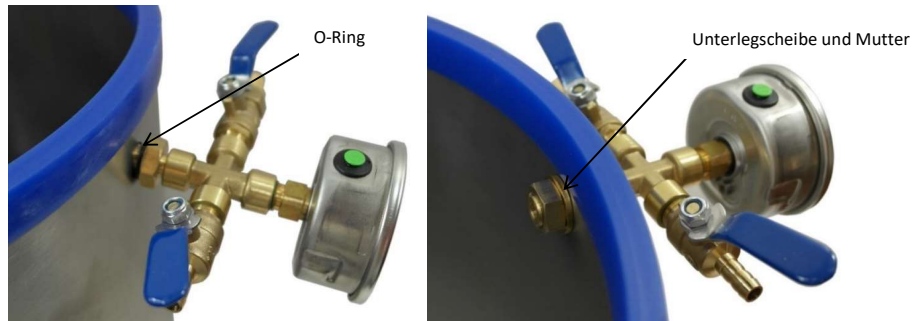
Foto Nr. 4: Ventilsinsel korrekt in der Bohrung eingesetzt.
